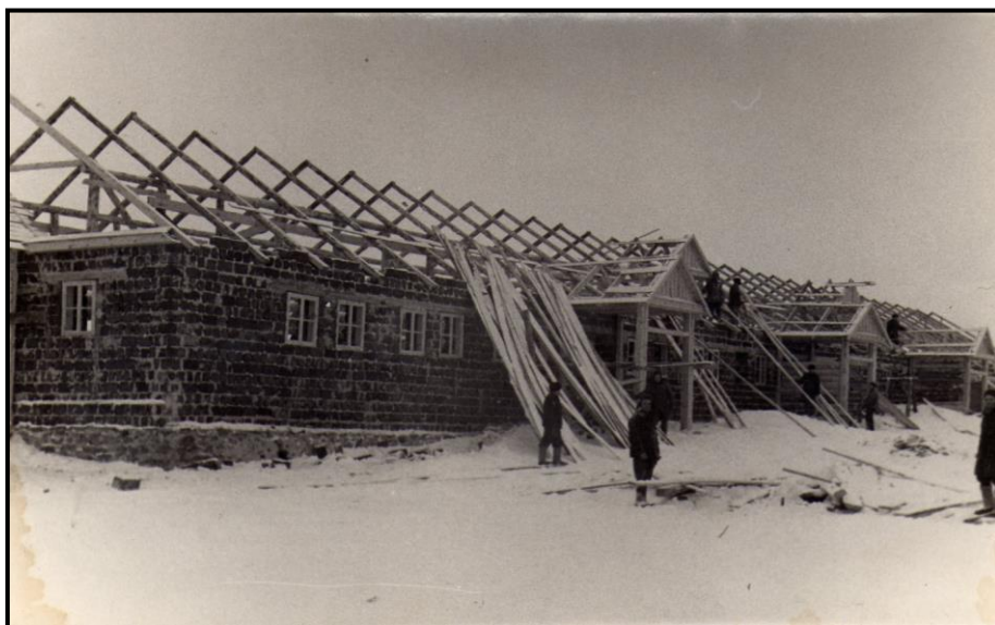
Строительство конюшни 1950 г.
